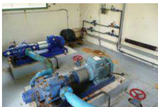
Fig. 2-e : Pompes de refoulement vers le réservoir
